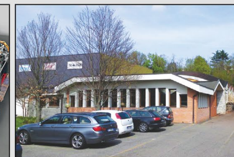
Stabilimento di Turbigo - Turbigo plant
