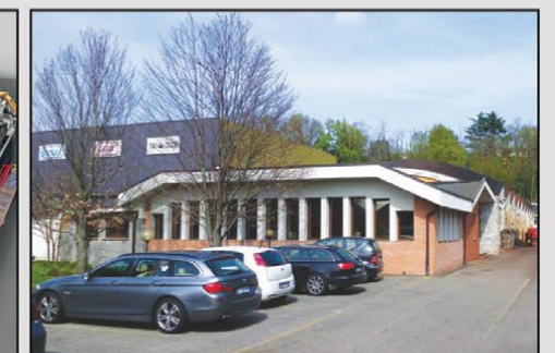
Stabilimento di Turbigo - Turbigo plant
